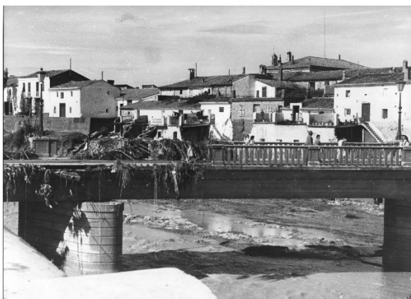
Barrio de Vistabella y Pont Vell (1957). Fuente: Ayuntamiento de Picanya.
