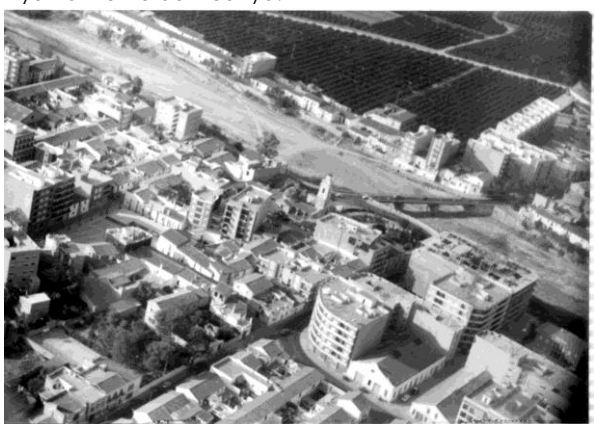
Vista aérea (1984). Fuente: Ayuntamiento de Picanya.
